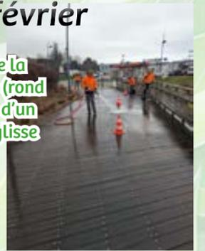
Nettoyage de la passerelle bois (rond point) et pose d'un grillage anti-glisse
