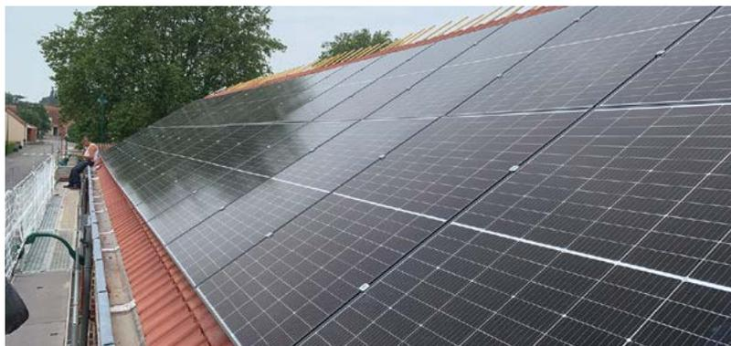
La pose des panneaux photovoltaïques sur la toiture de l'école Curie a débuté, les travaux seront terminés avant la rentrée scolaire. L'électricité produite sera d'abord utilisée en autoconsommation pour l'école puis dans un deuxième temps en autoconsommation collective, c'est-à-dire que le surplus de production alimentera d'autres bâtiments communaux.
