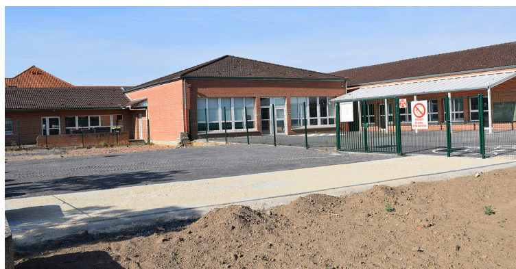
Le pavage de l'allée menant à la cour pour l'entrée des élèves est terminé.
