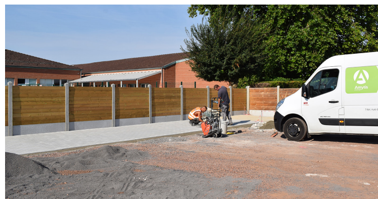
Le piétonnier a été créé le long du parking en schiste
